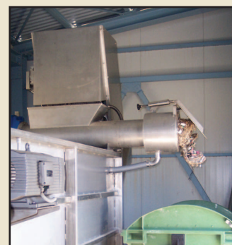
Απόρριψη συμπιεσμένων εσχαρισμάτων
